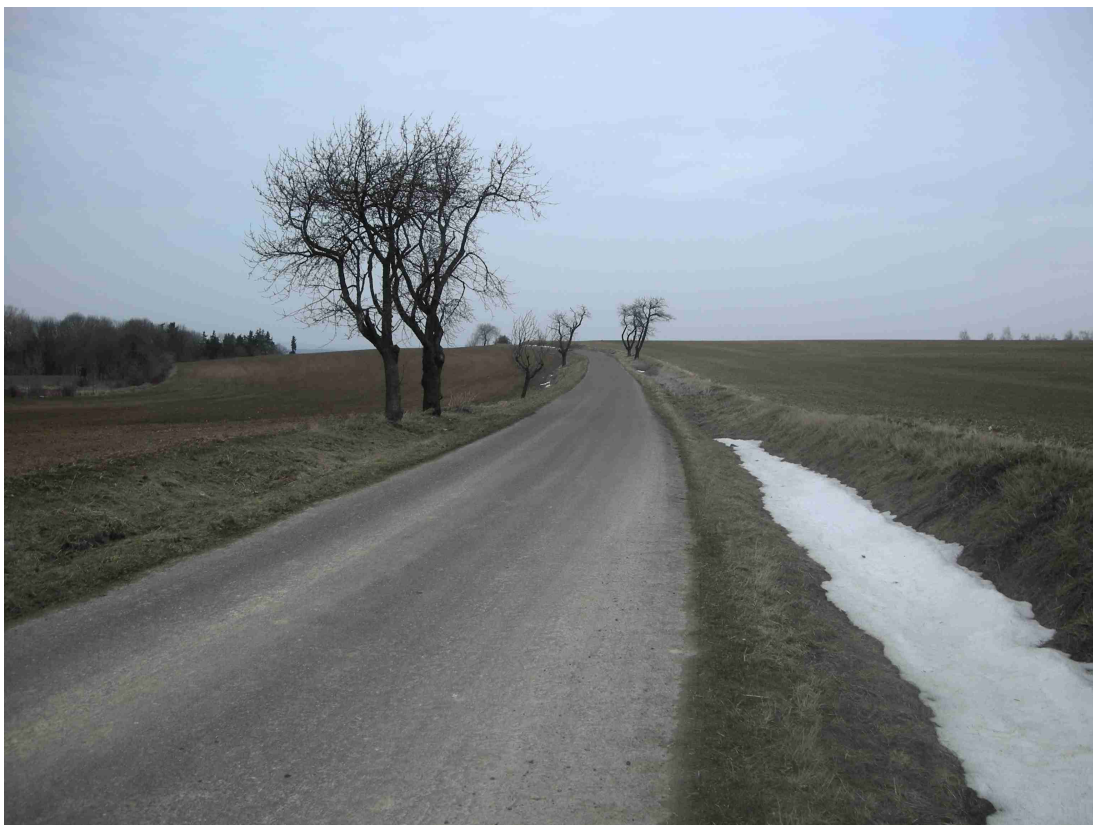
Obrázek 3, silnice s příkopy u pozemku 6401/4
