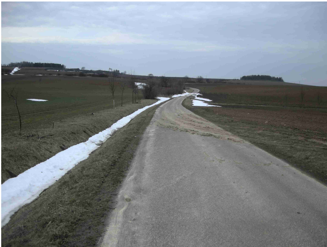
Obrázek 1, silnice s příkopy u pozemků 8401/11, 8401/18
