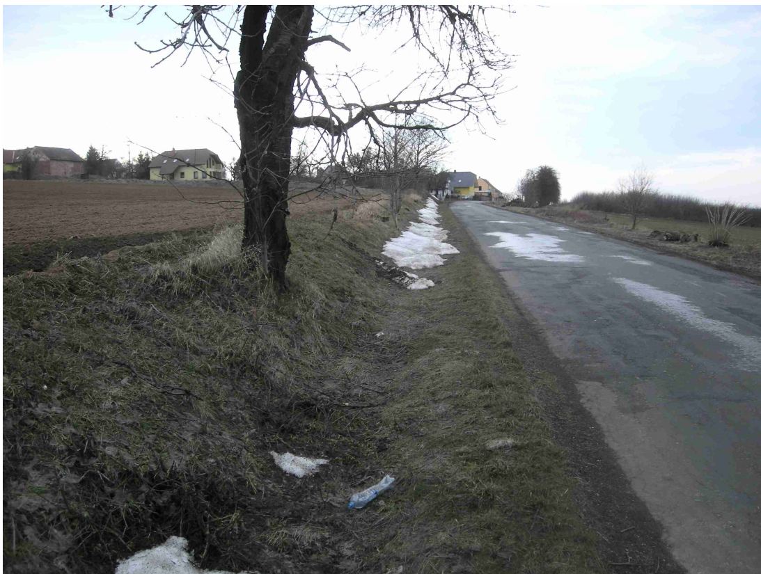
Obrázek 6, silnice s příkopy u pozemků 7202/10, 7202/14
