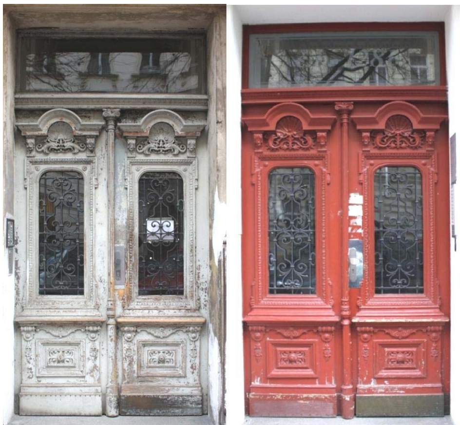
Obr. 5: Srovnání dveří dvou sousedních domů – před repasí a po ní
