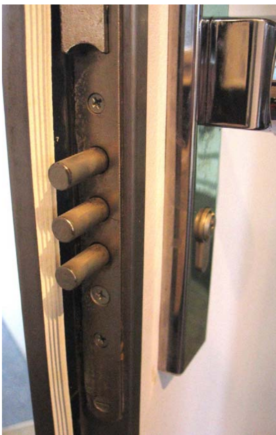
Obr. 17: Trojitý čep vícebodového zámků
