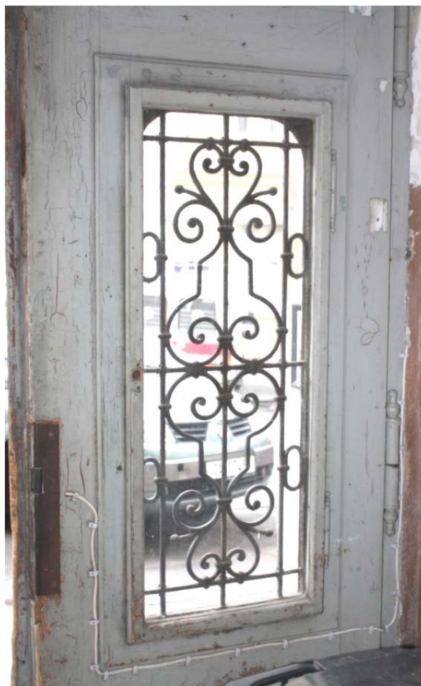
Obr. 3: Detail okenního otvoru ve dveřích
