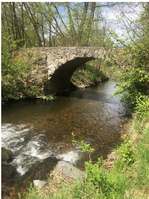
Obr. 59 – Kamenný most přes potok Polečnice na poutní trase z Českého Krumlova.
