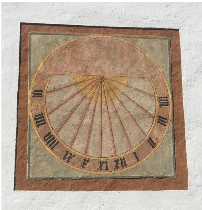
Obr. 21 – Pozdně středověké sluneční hodiny na jižní stěně věže.
