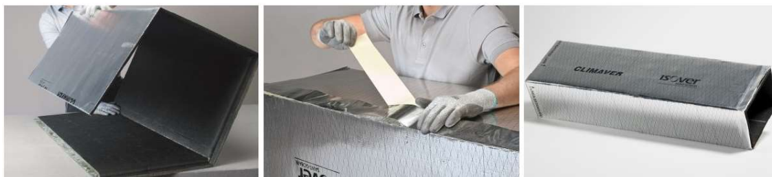
Obr. 1.27 Montáž potrubia z tuhých dosiek [17]
