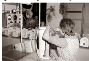
Obr. 81: Pracovnice podniku Elektro-Praga
