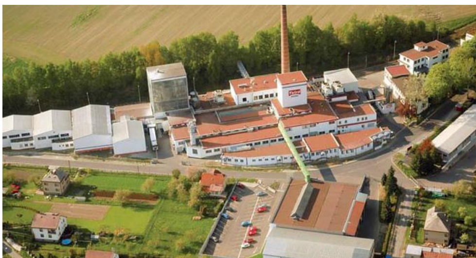
Obr. 97: Areál firmy Mlékárna Hlinsko, a.s.
