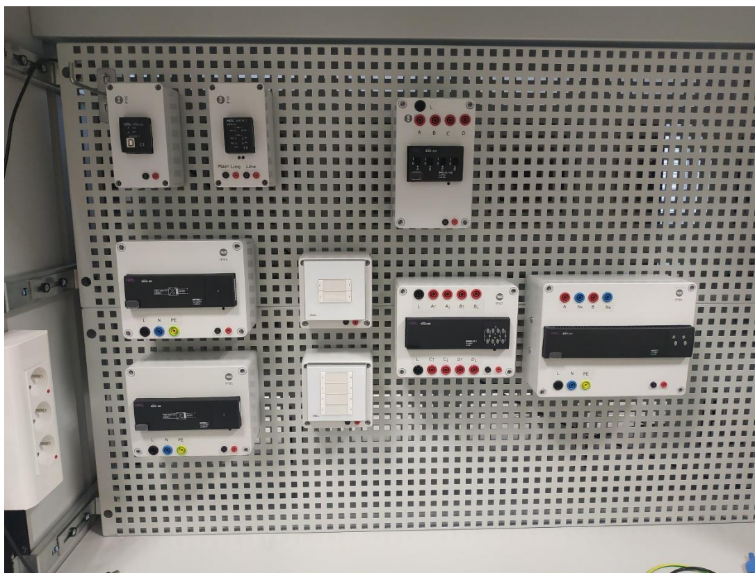
Obrázek 3.18 Zhotovené přípravky pro laboratorní úlohy
