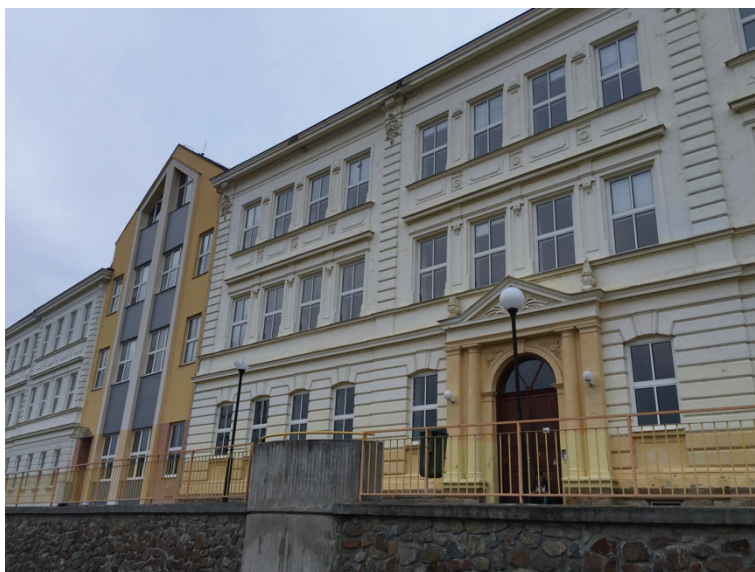
Obr. 4.28: Rosice – základní škola
