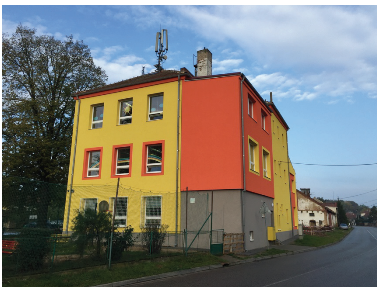
Obr. 4.25: Troubsko – mateřská a základní škola
