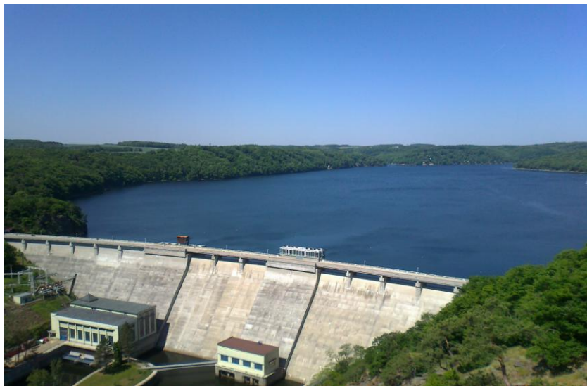
Obrázek 3 – Hráz vodního díla Vranov
