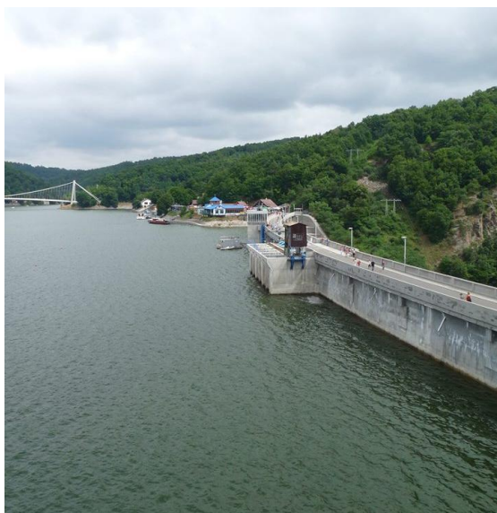
Obrázek 4 – Hráz vodního díla Vranov
