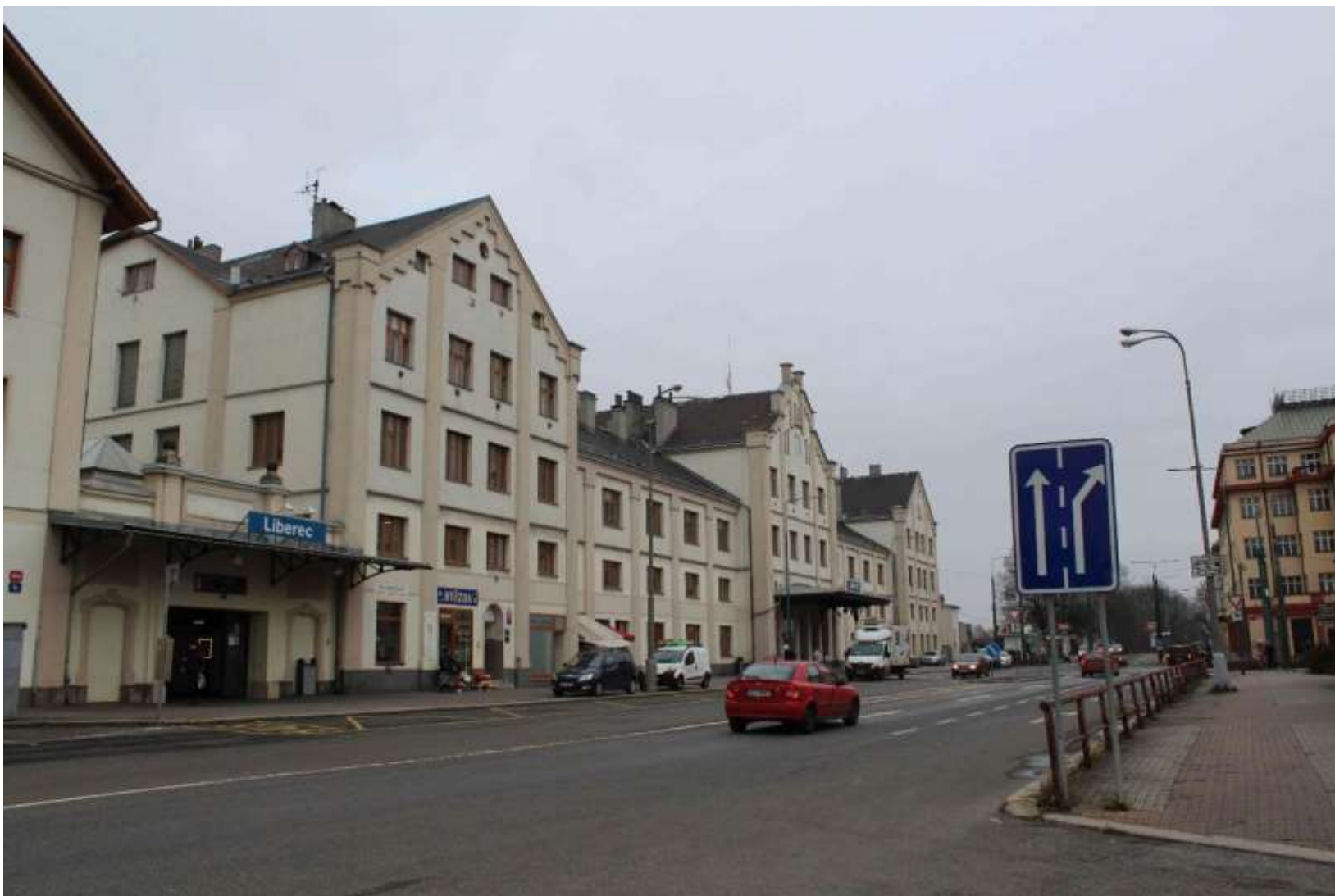
Obrázek 41: Nádraží Liberec – fotografie současného stavu výpravní budovy, listopad 2022, autor: Jiří Tarant.
