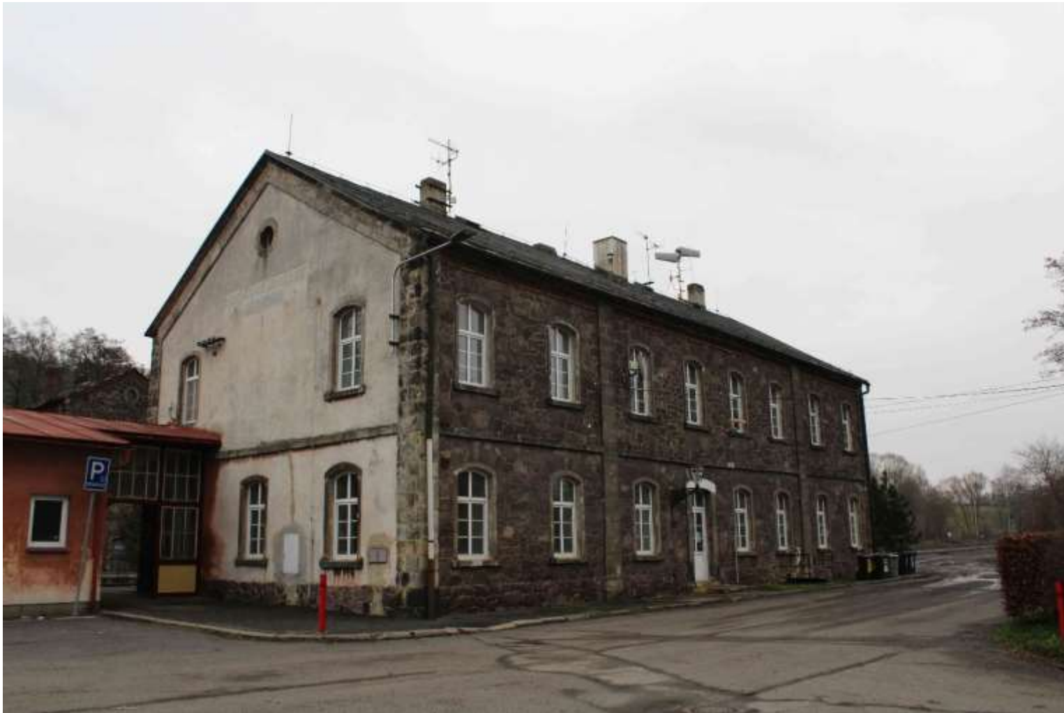
Obrázek 50: Stanice Hodkovice nad Mohelkou – výpravní budova, fotografie současného stavu, pohled z ulice, autor: Jiří Tarant
