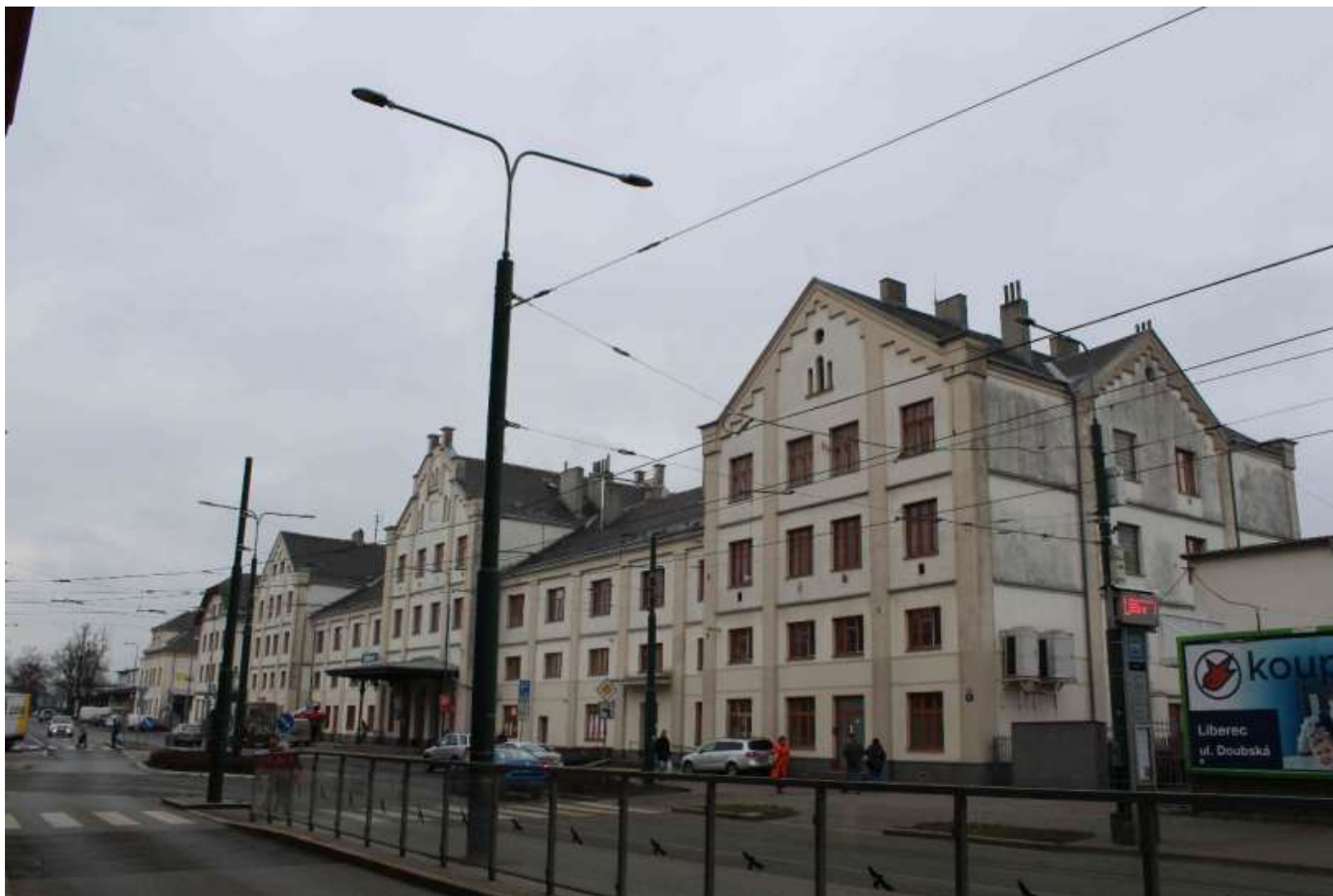
Obrázek 42: Nádraží Liberec – fotografie současného stavu výpravní budovy, listopad 2022, autor: Jiří Tarant
