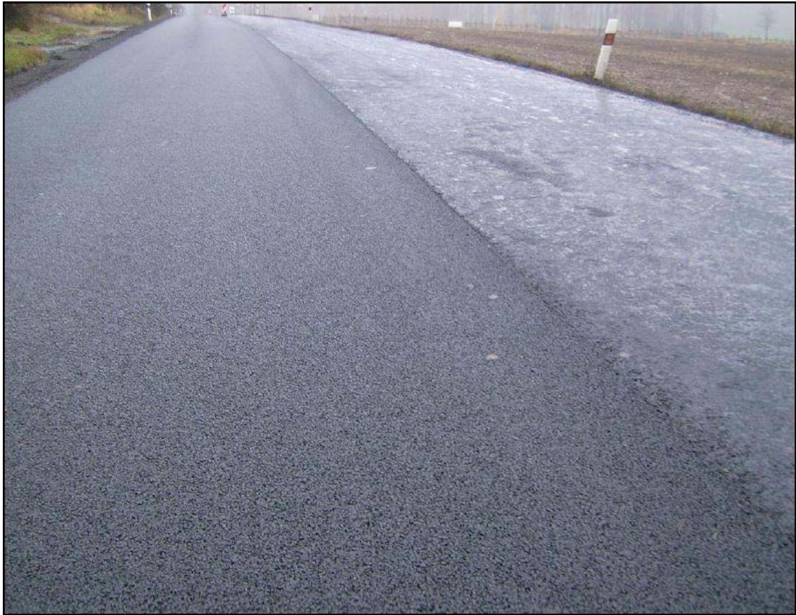
Obrázek 15 – drenážní asfaltový koberec (PA)
