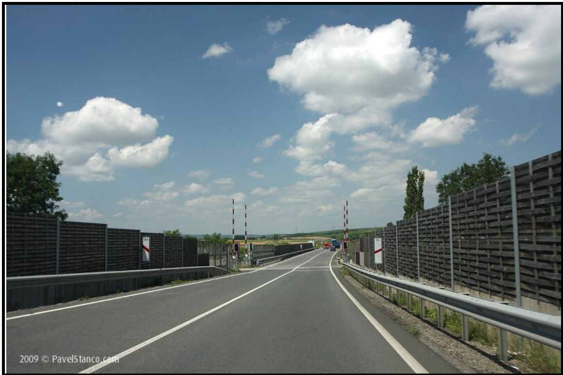
Obrázek 10 – protihluková stěna dřevěná [12]
