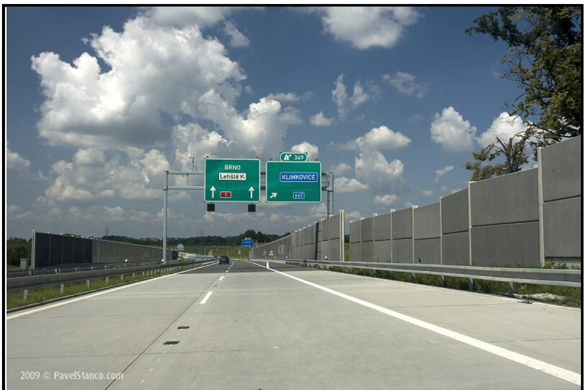
Obrázek 11 – protihluková stěna z betonových panelů [12]
