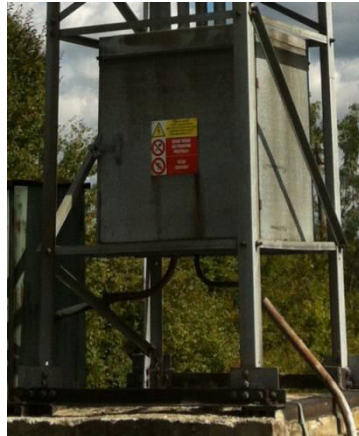
Obr. 17 Rámová část trafostanice
