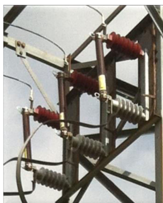
Obr. 11 Venkovní pojistky s omezovačem přepětí
