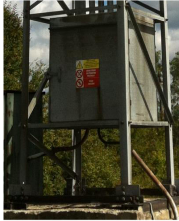
Obr. 17 Rámová část trafostanice
