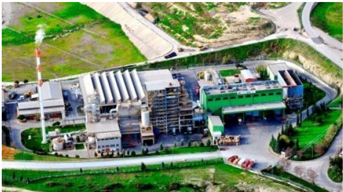
Příloha č. 10: pohled na areál spalovy Izaydas v TR. Zdroj (Izaydas,2017)
