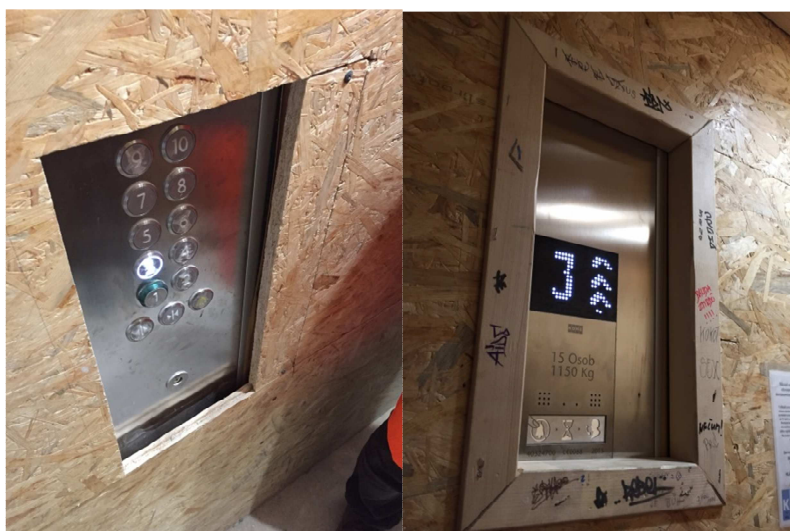
Obrázek 32 Ochranná opatření výtahu
