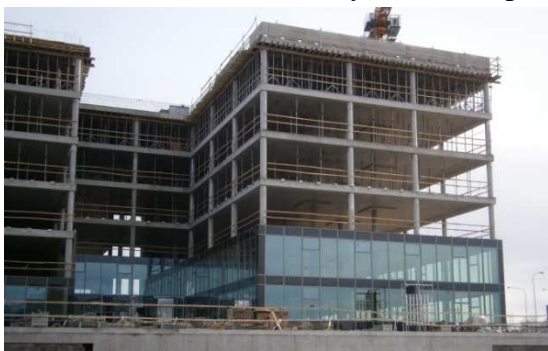
Obrázek 10 Postup montáže LOP
