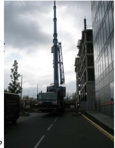
Obrázek 46 (c) Realizace jeřáb
