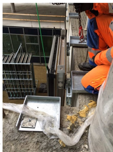
Obrázek 11 Kotva pro zavěšení bloku fasády
