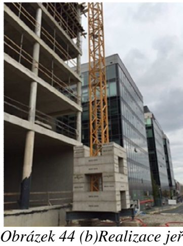
Obrázek 45 Základ pod jeřáb hutnění na 80 MPa
