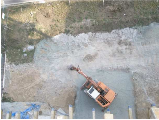
Obrázek 45 Základ pod jeřáb hutnění na 80 MPa
