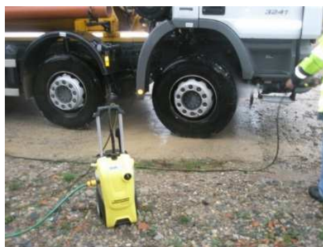
Obrázek 36 Čištění aut vyjíždějících ze stavby
