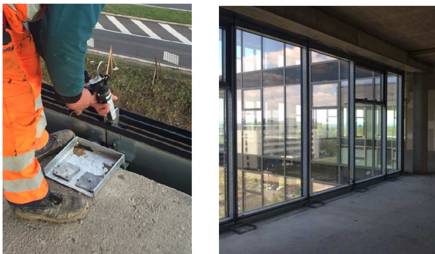
Obrázek 15 Dotěsnění bloků fasády ve spojích
