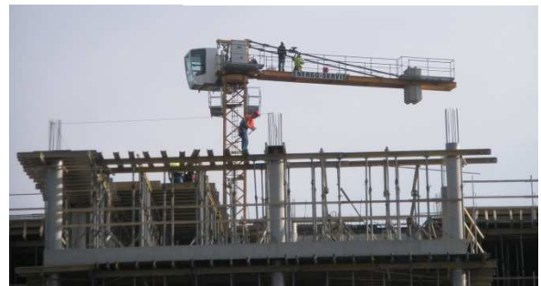
Obrázek 47 Montáž protizávaží
