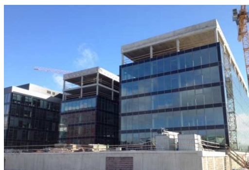
Obrázek 9 Postup montáže LOP
