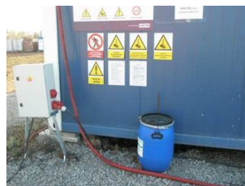
Obrázek 35 Havarijní souprava pro únik provozních kapalin ze strojů
