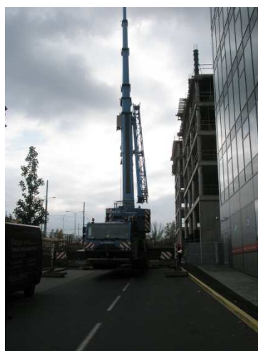
Obrázek 40 Práce autojeřábu MK 88
