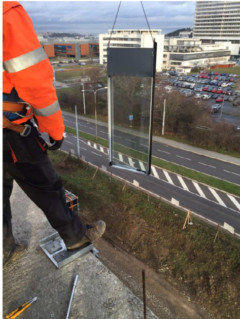
Obrázek 14 Montáž blokové fasády
