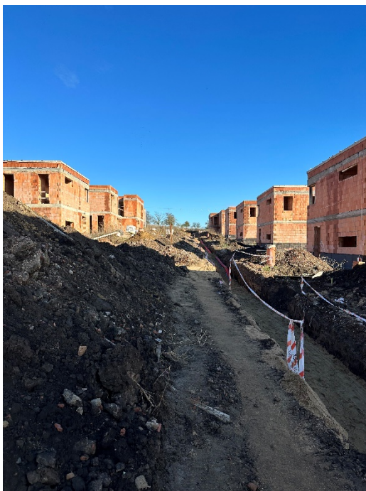
Obr. 15: Zasypávaný výkop lokality Rousínov.
