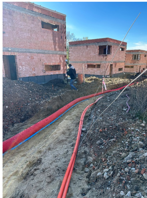
Obr. 16: Kabelové vedení v otevřeném výkopu.
