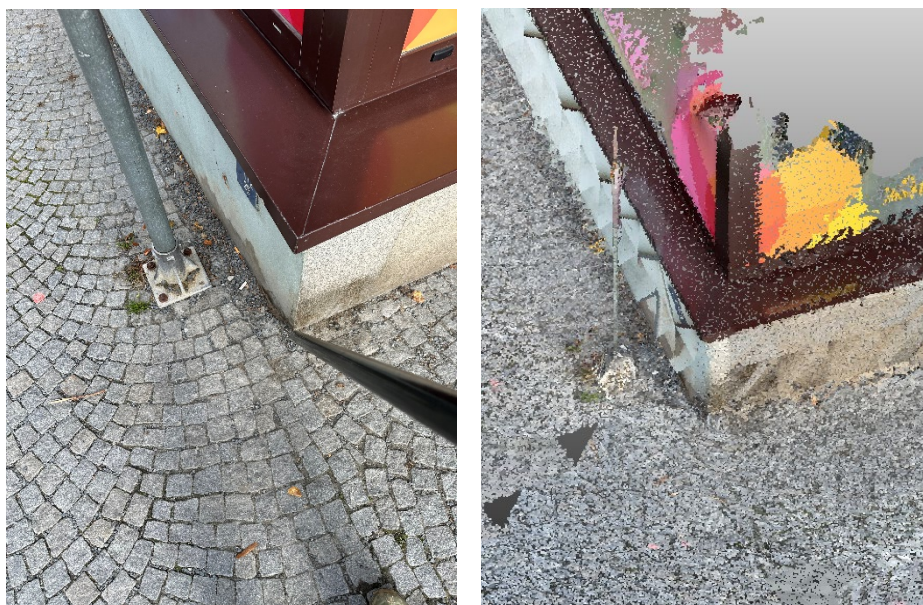
Obr. 20 a 21: Stabilizace rohem domu a tatáž situace v mračnu.
