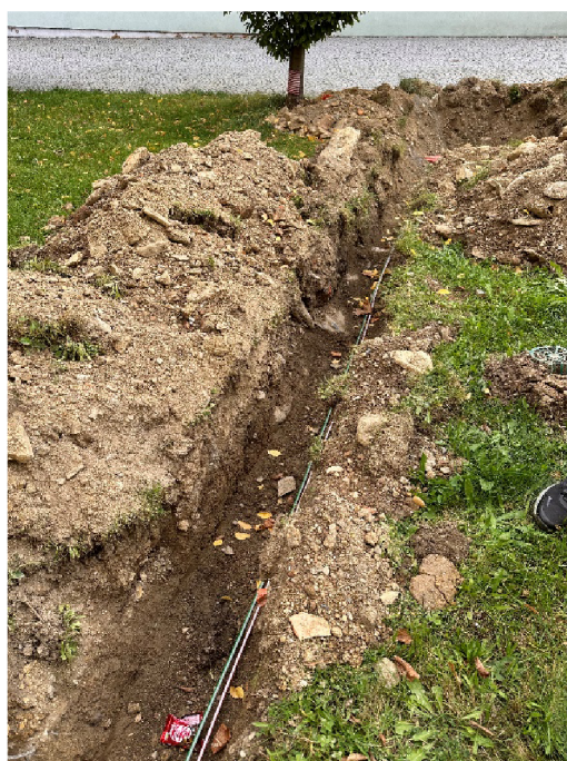
Obr. 13: Kyneta s uloženými trubičkami.
