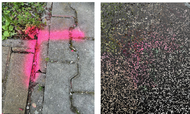
Obr. 22 a 23: Signalizace rohu rozhraní povrchů sprejem a situace v mračnu.
