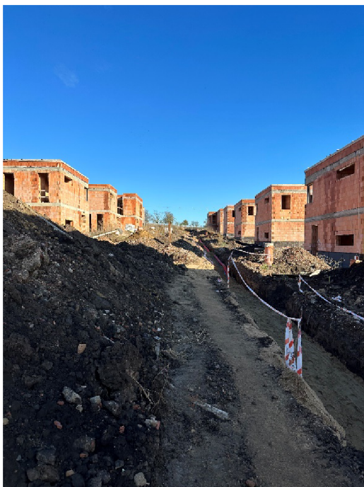
Obr. 15: Zасыпávaný výkop lokality Rousínov.
