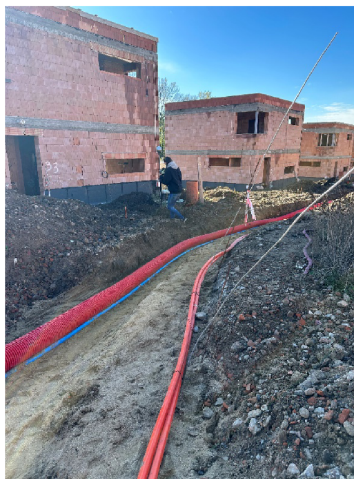
Obr. 16: Kabelové vedení v otevřeném výkopu.
