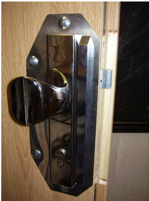
Obrázek 14 : Příklad dveřního kování s ochranou proti páčení mezi zárubní a zámkem
