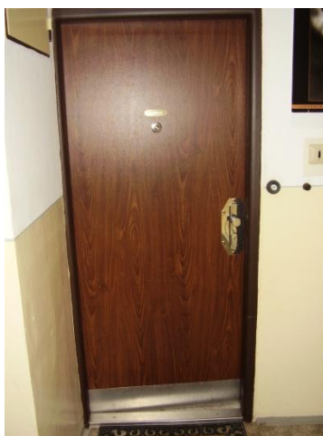
Obrázek 16 : Dveře opatřené ocelovým prahem a spodním oplechováním
