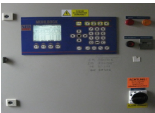
Obr. 16: Manuální externí záznamové zařízení sušárny řeziva
