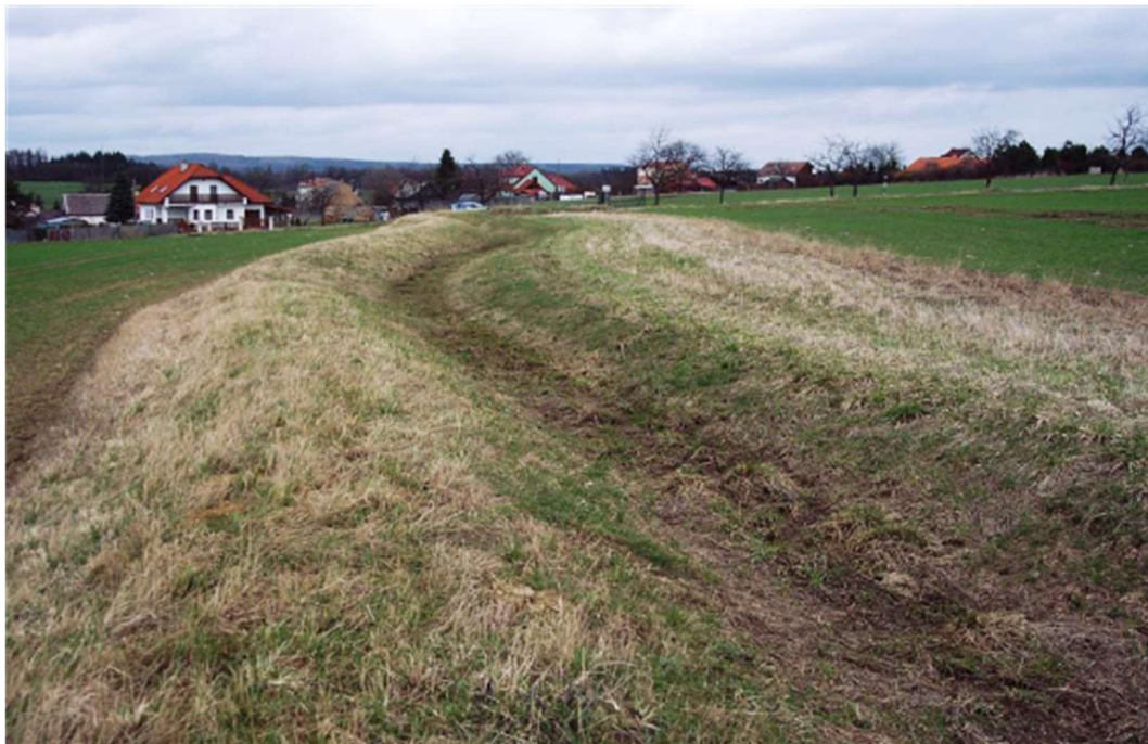
Obr. 45: Ilustrační obrázek průlehu s hrázkou [28]
