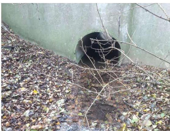
Obr. 15: Foto dolní strany propustku
