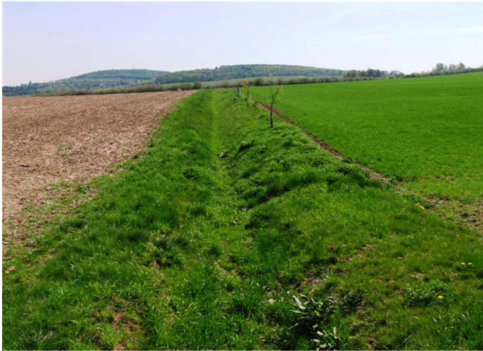
Obr. 44: : Ilustrační obrázek průlehu bez hrázky [28]
