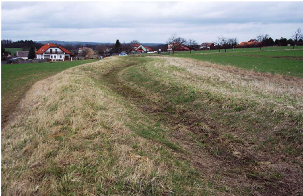
Obr. 45: Ilustrační obrázek průlehu s hrázkou [28]
