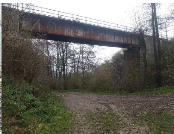
Obr. 16: Foto železničního nadjezdu nad vodním tokem (po pravé straně) a polní cestou (pohled po proudu)
