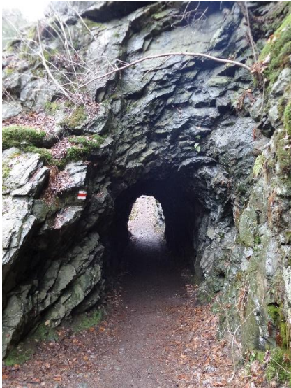
Obrázek 4: Pěší tunel na Riegrově stezce (foto: 2016, Martin Adamec)
