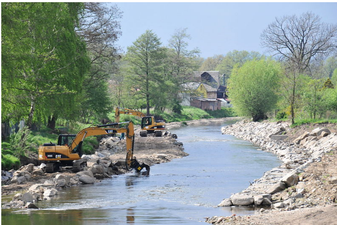
Příloha č. 4: Fotodokumentace z obnovy koryta Lužické Nisy po povodni 2010
