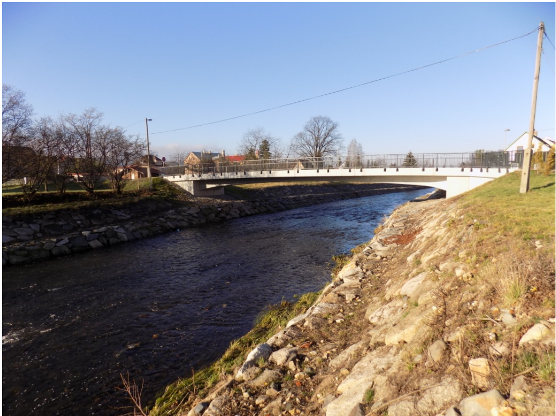
Obr. č. 24: Pátý objekt - most U Nývltů nacházející se na vodním toku Lužické Nisy ř. km. 4, 514. (autor, 2016).
