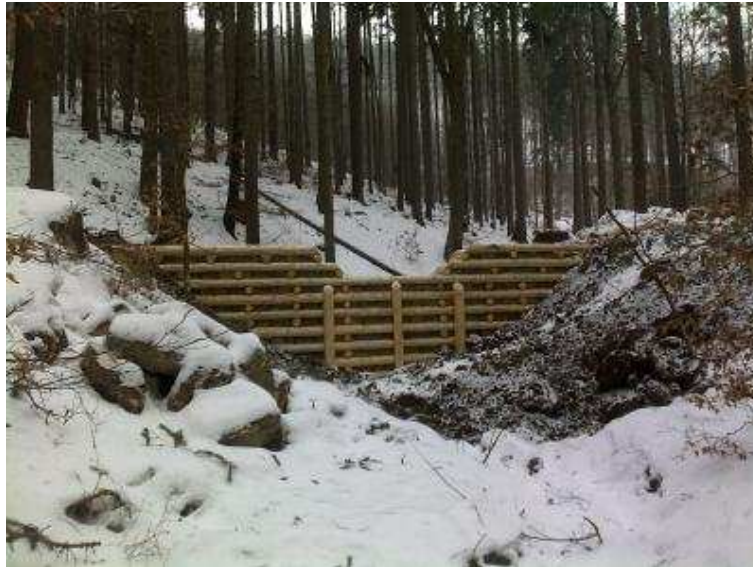
Obr.1: Přehrážka z kulatiny
