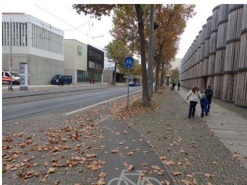
Obrázek 39: Začátek jízdního pruhu pro cyklisty z přidruženého prostoru. Trajektorie cyklisty a motorových vozidel jsou bezkolizní, nulové výškové rozdíly (Atelis 2023)
