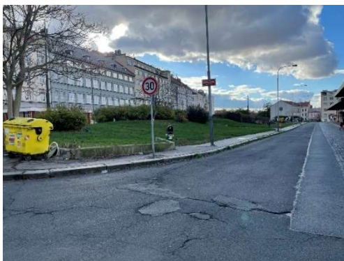
Obrázek 18: Pás zeleně přilehlý k ulici Na Žertvách – pohled od autobusového nádraží směrem ke křižovatce ulice Zenklova a ulice Na Žertvách (autorka 2023)
