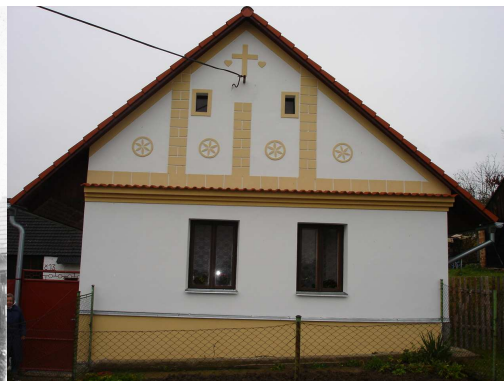
Obr. č. 66 Štít chalupy č.p.13 po rekonstrukci.
