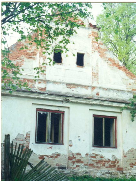
Obr. č. 56 Štít obytného domu č.p. 3 před rekonstrukcí.
