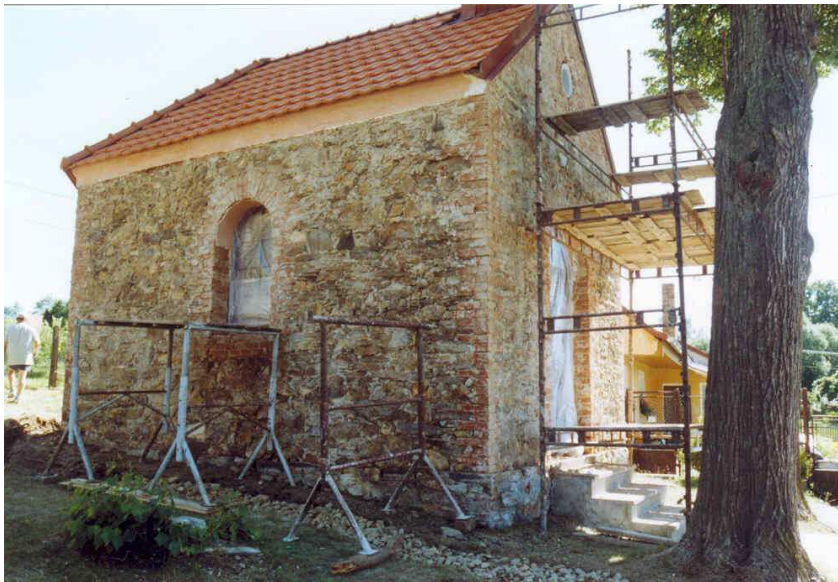
Obr. č. 53 Spojení cihly a kamene na třebišťské kapličce.
