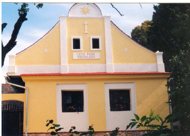
Obr. č. 57 Štít obytného domu č.p. 3 po rekonstrukci.
