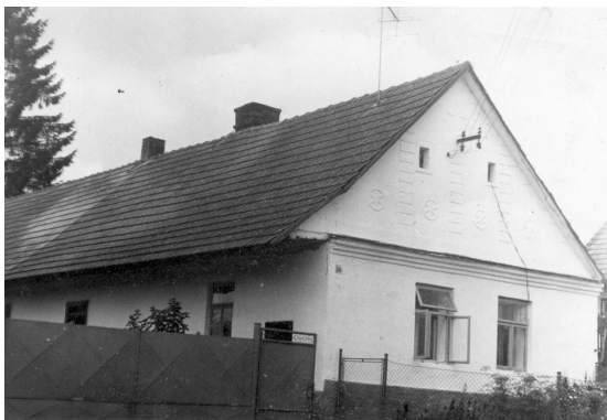
Obr. č. 65 Štít chalupy č.p.13 před rekonstrukcí.
