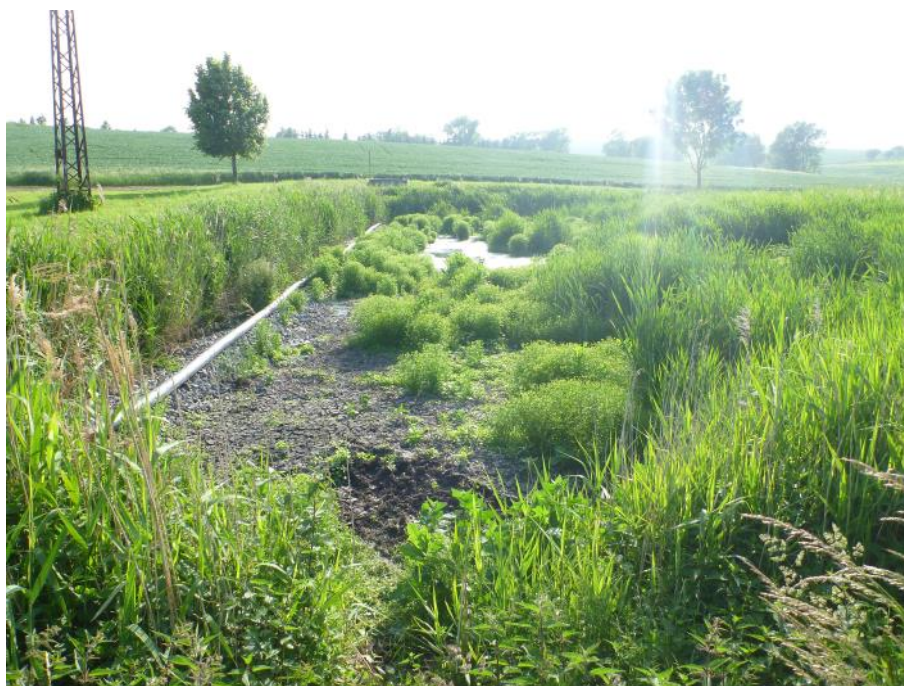
Obrázek 11: Pohled na revizní šachtu a kořenové pole v červnu 2014.
