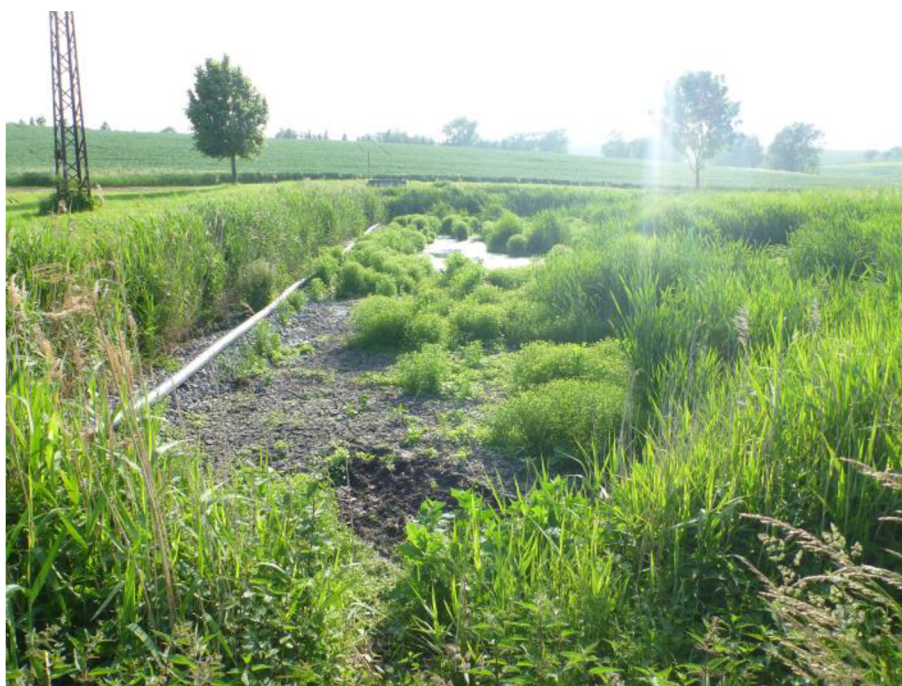
Obrázek 11: Pohled na revizní šachtu a kořenové pole v červnu 2014.
