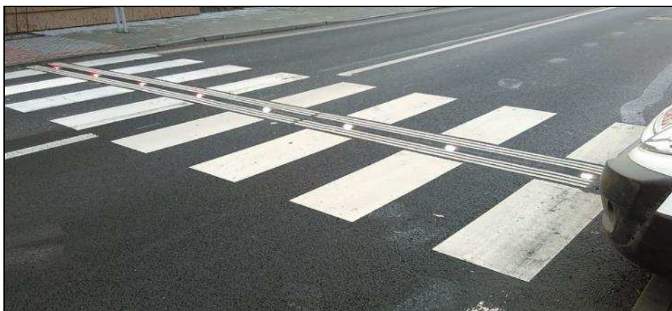
Obr. 17: Přechod osvětlený svítidly zapuštěnými do vozovky. Zdroj (36)
