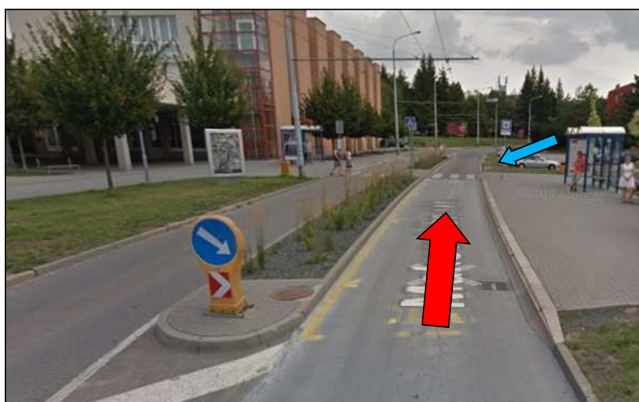
Obr. 30: Přechod na ulici Makovského nám., pohled ze strany řidiče. Zdroj (vlastní)
