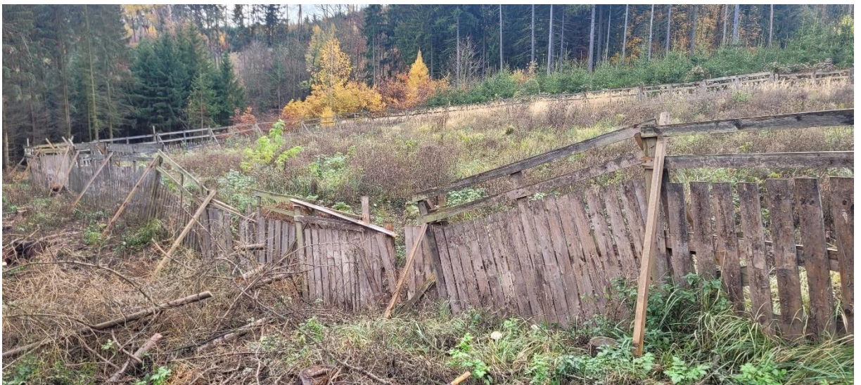
Obrázek 30-Poškozené plotové pole
