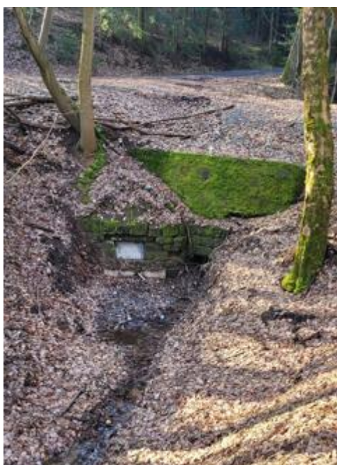
Obrázek 9-Deskový propustek
