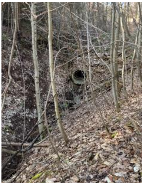
Obrázek 14-Trubní propustek
