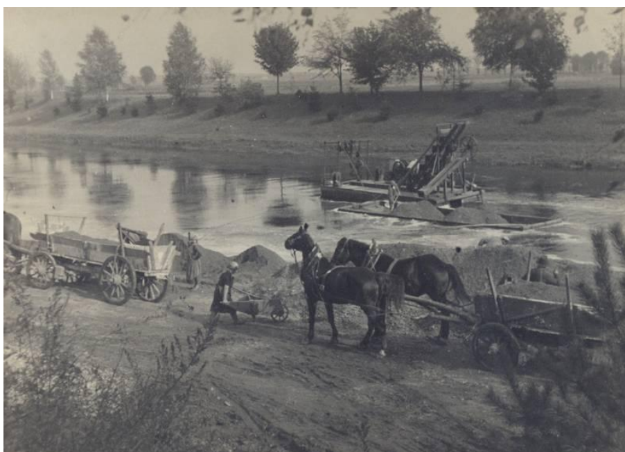
Obr. 25: Těžba štěrkopísků pomocí plovoucího bagru z koryta Labe u Smiřic (zdroj: Smiřice a Holohlavy, 2004)
