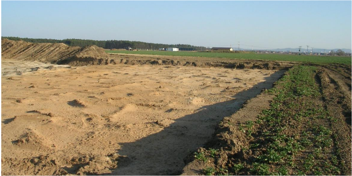
Obr. 14: Skrývka orniční vrstvy (foto: J. Braun, duben 2013)
