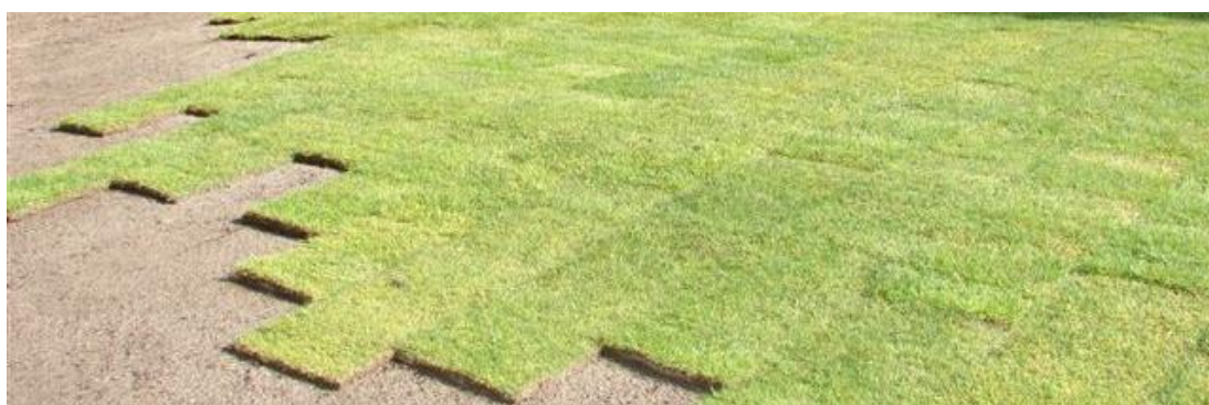
Obr. 8: Odpaliště 12 – pokládka travního koberce – 3,4/2018 (foto pořízeno autorem, 2018).
