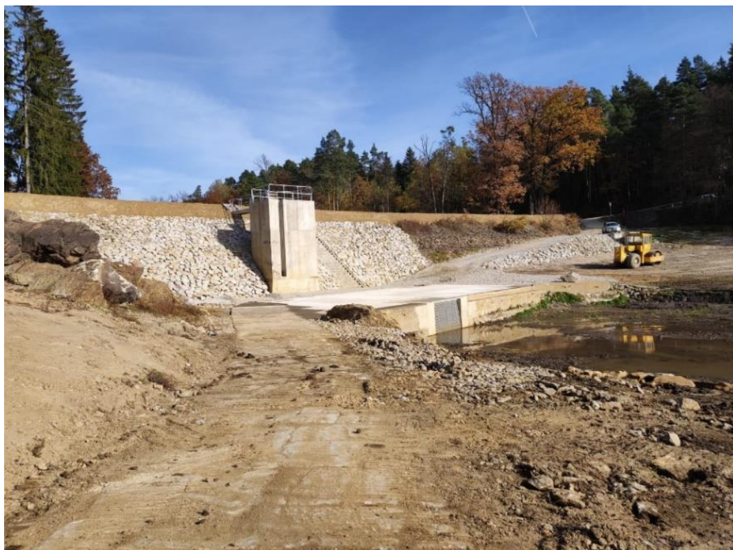
Obrázek 3.17 Návodní strana hráze (zpracování vlastní)
