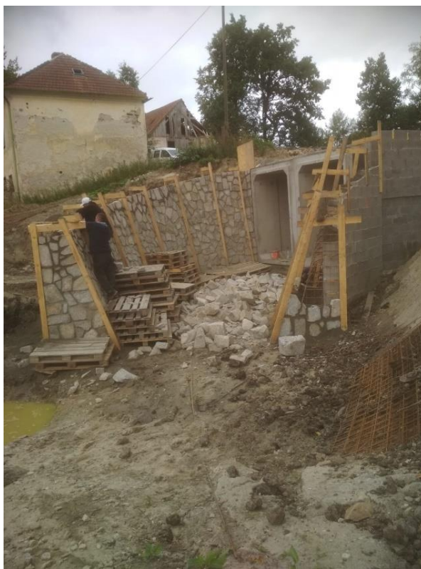
Obrázek 3.23 Kamenování zdi (zpracování vlastní)
