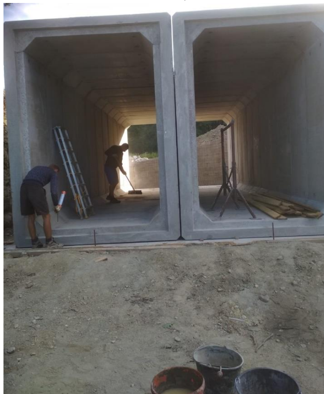
Obrázek 3.21 Usazení rámových prefabrikátů (zpracování vlastní)
