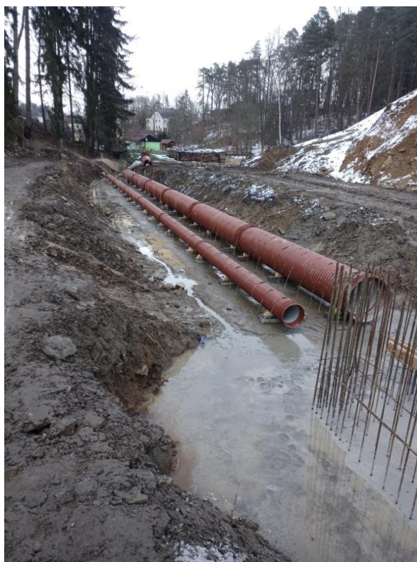
Obrázek 3.10 Instalace výpustného potrubí (zpracování vlastní)
