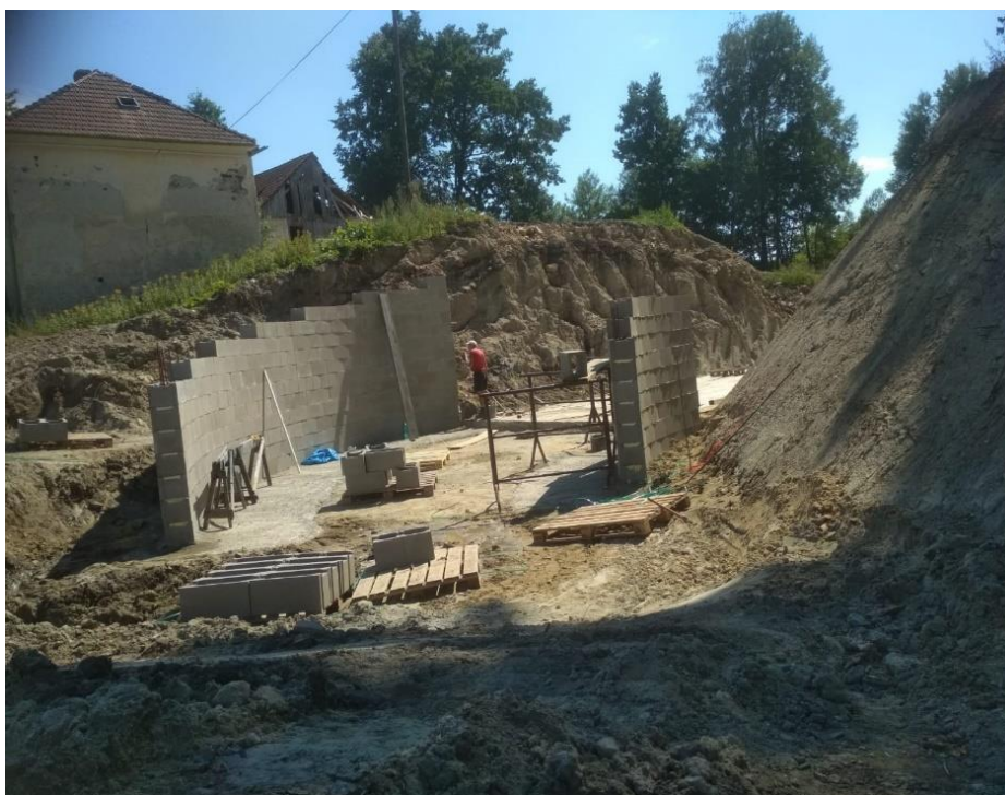
Obrázek 3.22 Stavba zdi (zpracování vlastní)
