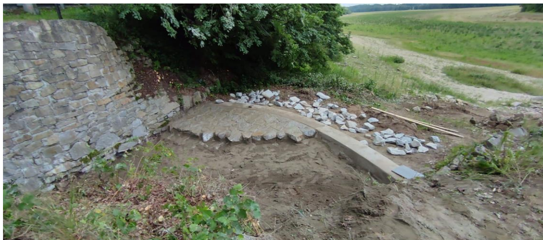
Obrázek 3.14 Oprava bezpečnostního přelivu (zpracování vlastní)
