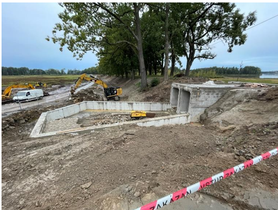
Obrázek 3.24 Probíhající práce na bezpečnostním přelivu (zpracování vlastní)
