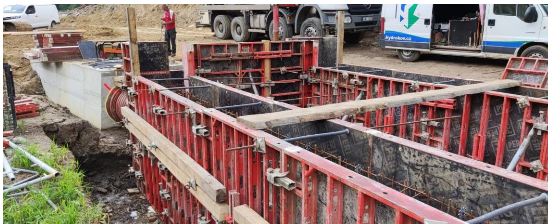
Obrázek 3.11 Betonáž vývařiště (zpracování vlastní)
