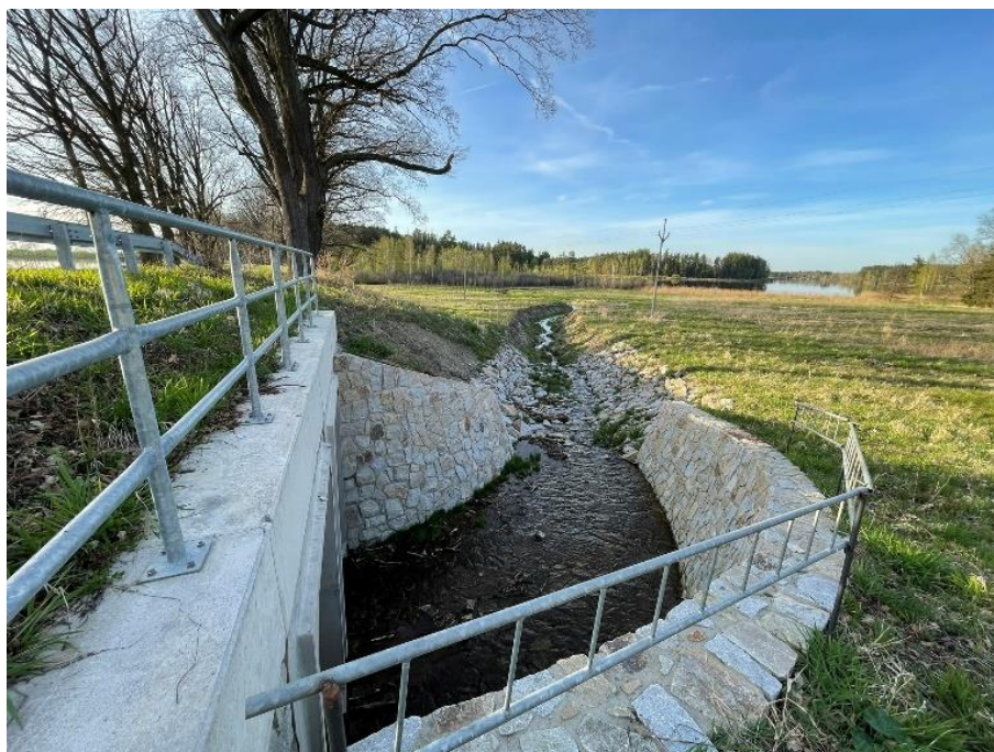
Obrázek 3.26 Bezpečnostní přeliv po rekonstrukci – pohled z hráze (zpracování vlastní)
