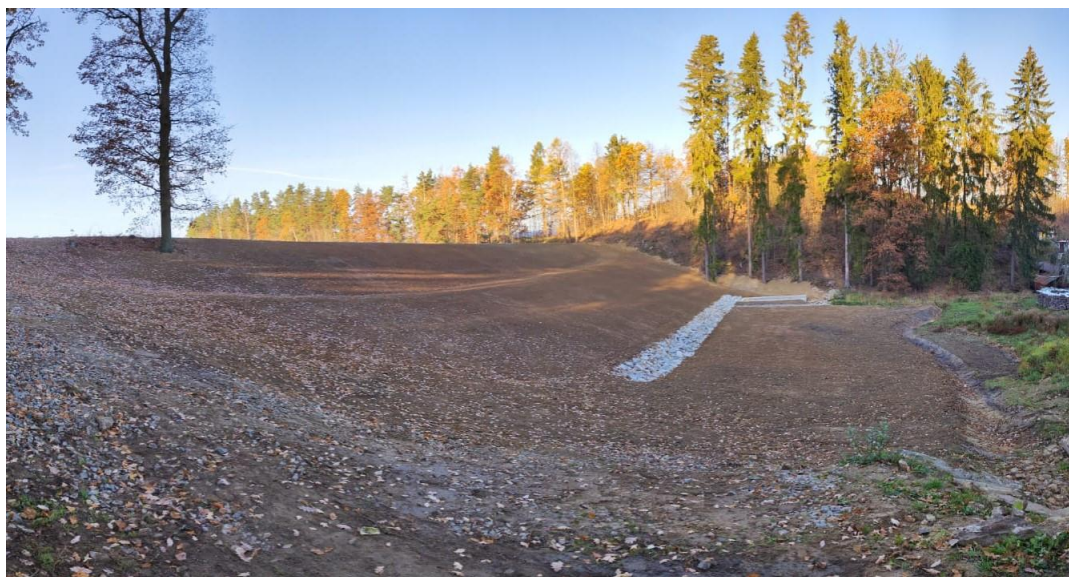
Obrázek 3.16 Vzdušná strana hráze (zpracování vlastní)
