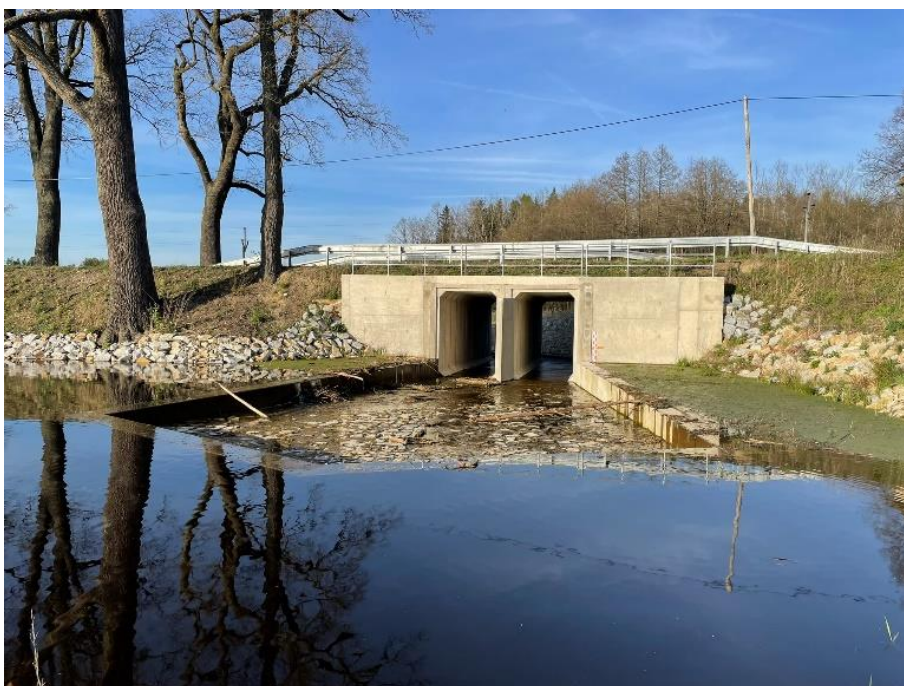
Obrázek 3.25 Bezpečnostní přeliv po rekonstrukci – pohled z rybníka (zpracování vlastní)
