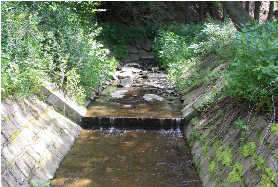
Foto 1: Antropogenní úprava se skalním prahem (pod mostem)
