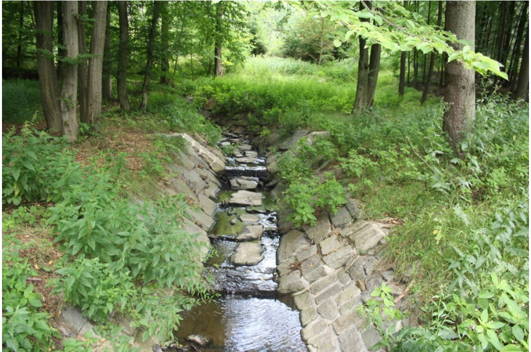
Obr. . 11: Antropogenní úprava potoka v blízkosti mostu
