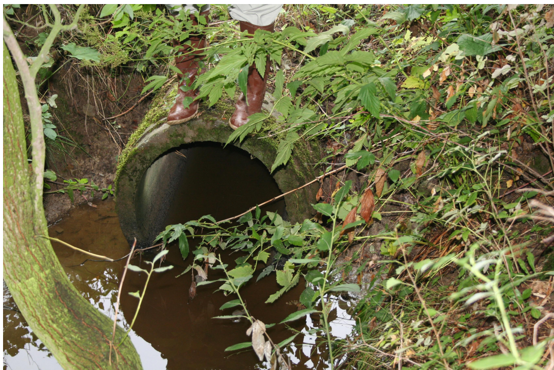
Foto 6: Konec zatrubn ní (pramenný úsek)
