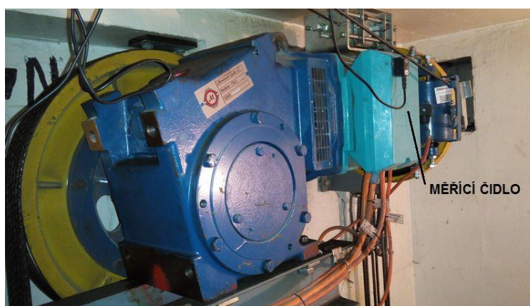
Obr. 28 Upevněné měřící čidlo na pohonu
