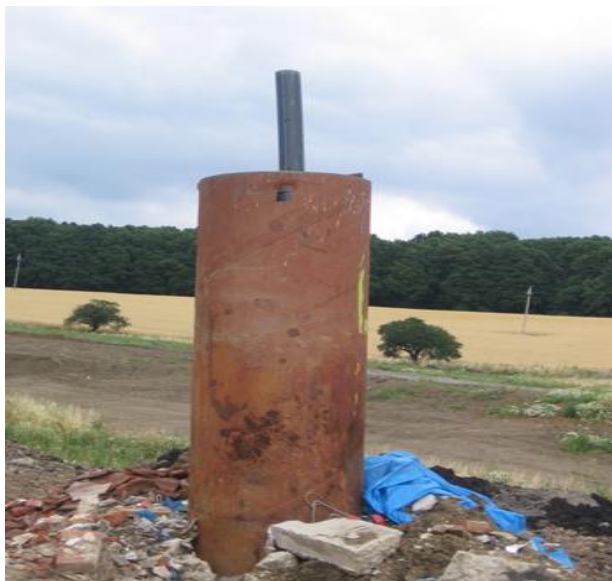
Obr. č. 7 Plynová studna, chráněná ocelovou skruží (zdroj: vlastní)
