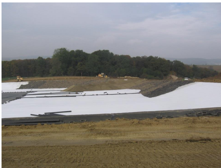
Obr. č.10 Výstavba skládky (zdroj: vlastní)
