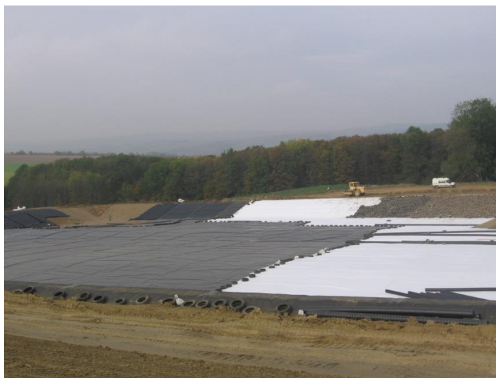
Obr. č. 11 Pokládání těsnícího systému (zdroj: vlastní)
