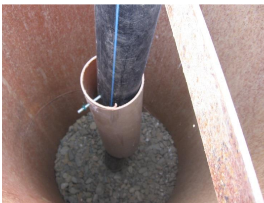
Obr. č. 13 Plynová studna obsypána kamenivem s ocelovou výpažnicí (zdroj: vlastní)
