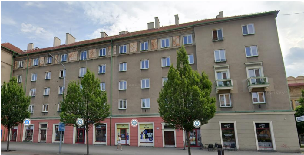
Obrázek 106 – Pohled na řešený bytový dům
