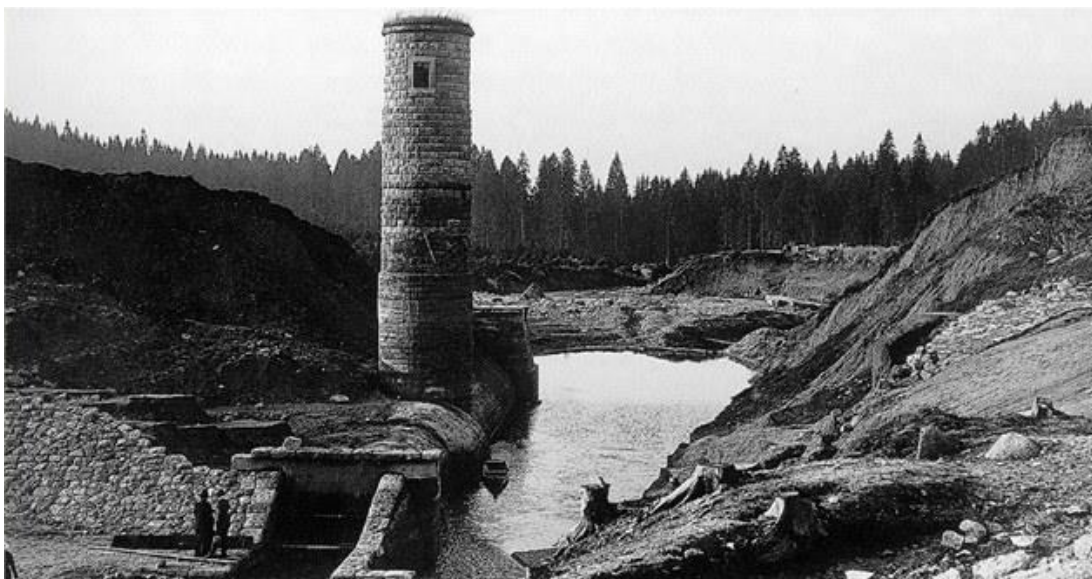
Foto č. 5 Protržená hráz přehrady Bílá Desná (Žák a kol., 2006)
