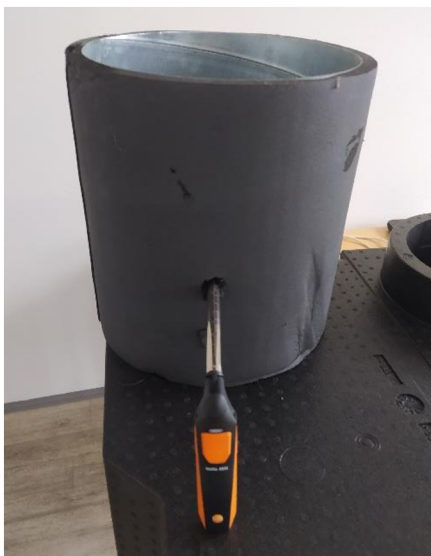
Obrázek 7.2 Měření průtoku výparníkové komory
