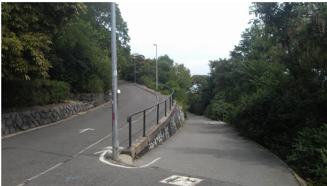
Obr.č. 9, Křižovatka hlavních cest, na níž je jasně patrný výškový rozdíl a vandalismus na opěrné zdi stoupající cesty. Zdroj: vlastní
