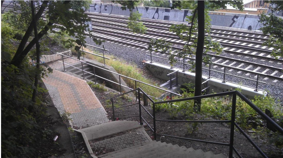
Obr.č. 22, Vstup do podchodu pod dráhou Nového spojení je nepřehledný, komplikovaný a špatně sociálně kontrolovatelný. Zdroj: vlastní
