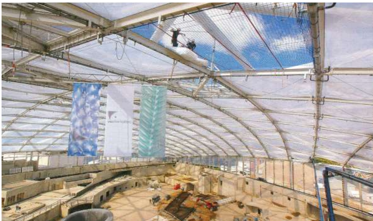
Osazování ventilačních klapek ve střešním pláští (fotografie). In: ZOO LEIPZIG GmbH. Tropical Experience World Gondwanaland. Leipzig: LEIPZIGER BLÄTTER, 2011
