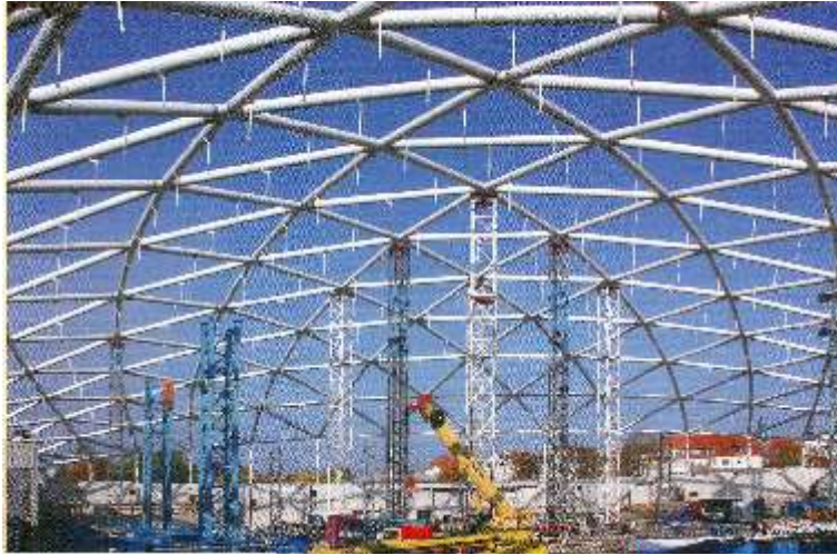
Montáž hlavní nosné konstrukce – Gondwanaland ZOO Lipsko
