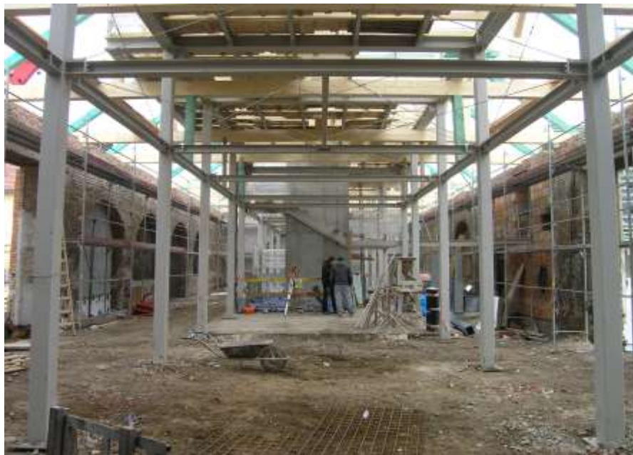
Pavilon ve fázi výstavby
