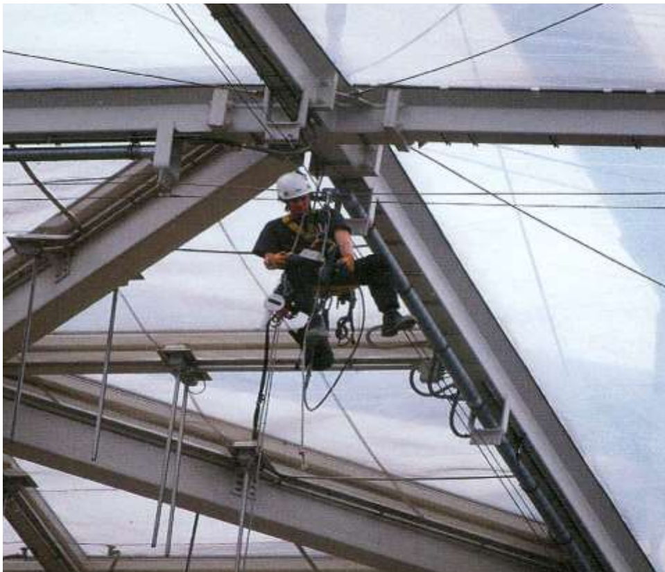
Osazování potrubí systému mlžení (fotografie). In: ZOO LEIPZIG GmbH. Tropical Experience World Gondwanaland. Leipzig: LEIPZIGER BLÄTTER, 2011
