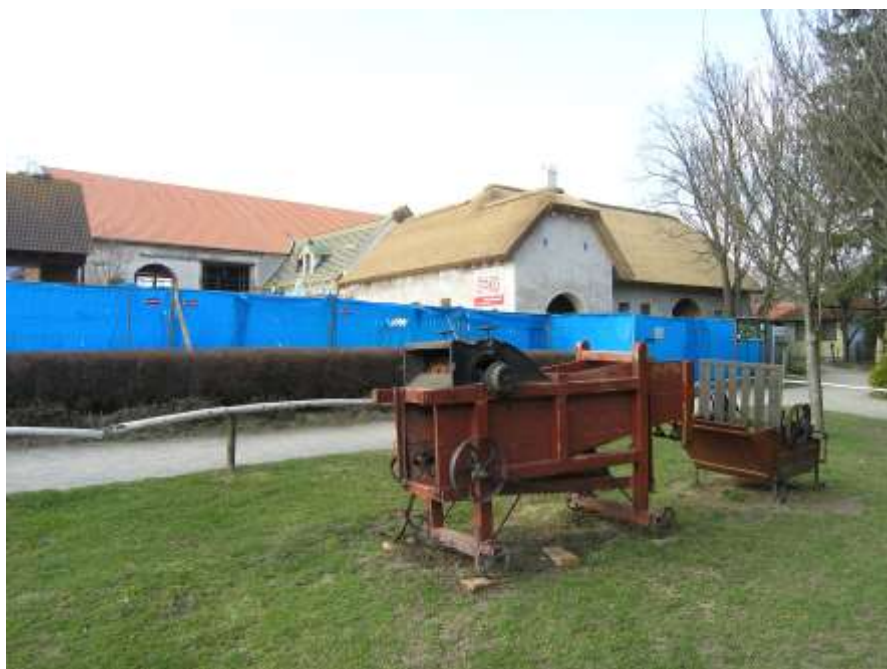
Před dokončením – březen 2011
