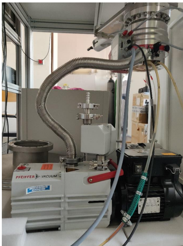
Obrázok 6.3: Vákuové pumpy použité pri evakuovaní vákuovej komory magnetronu.
