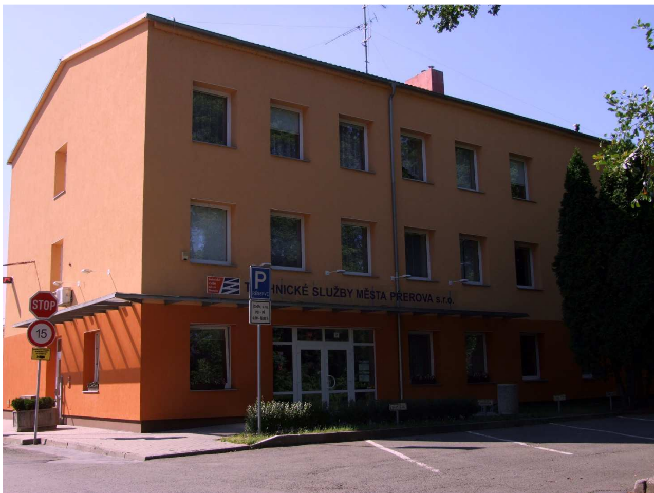
Obr. 1 Sídlo společnosti Technické služby města Přerova (foto: TsmPr)
