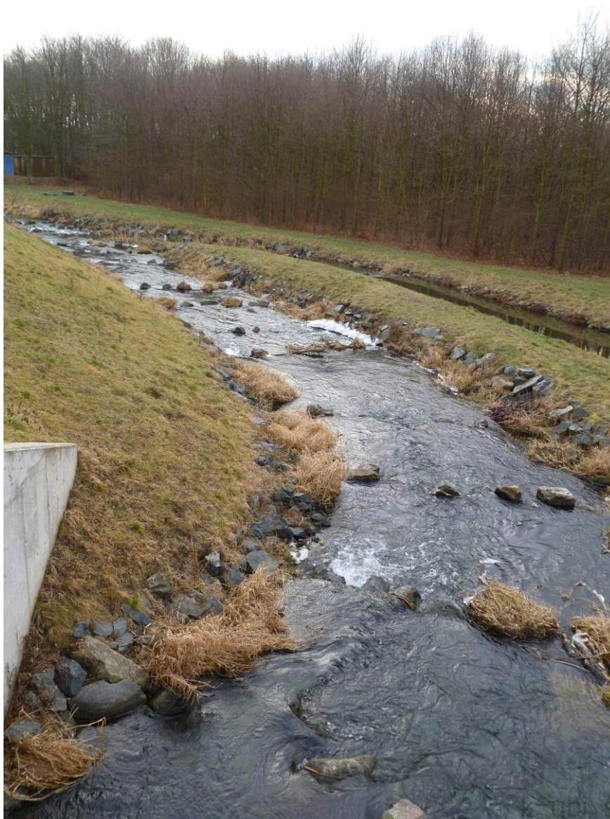
Obrázek 4.5 „Vzorový“ RP na jezu Bulhary (Dyje ř. km 39,9). Délka 210 m, sklon 1:56, minimální šířka ve dně 4 m a průtok 2 m 3 .
