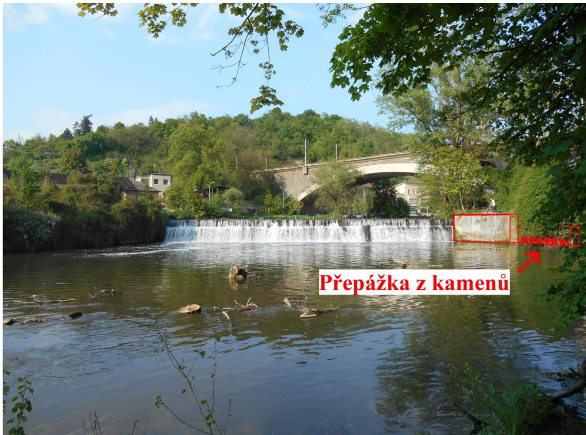
Obrázek 5.4 Schéma umístění vstupu RP jezu Obřany.
