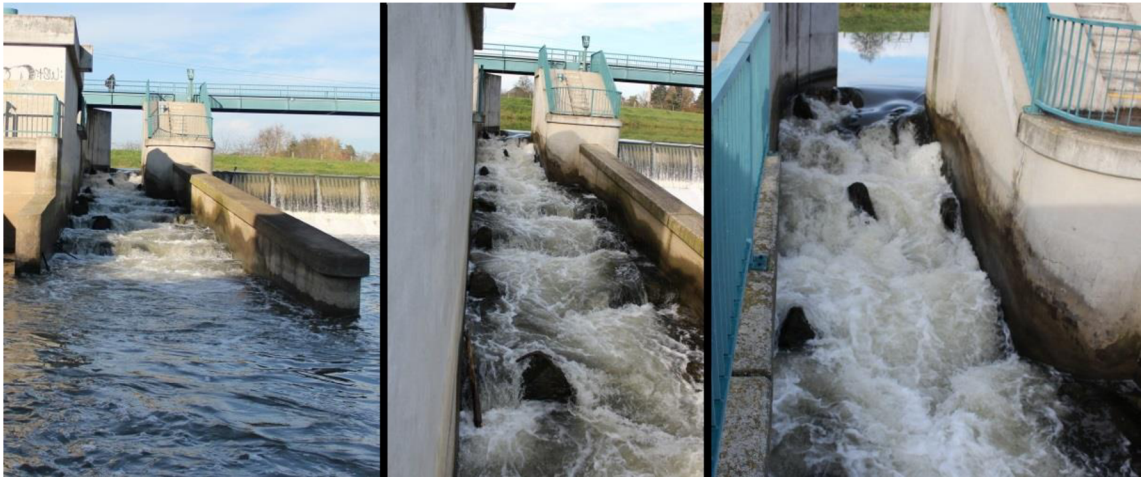
Obrázek 4.8 Příklad migrační rampy ve Veselí nad Moravou u MVE. O funkčnosti tohoto rybího přechodu se neustále vedou spory.
