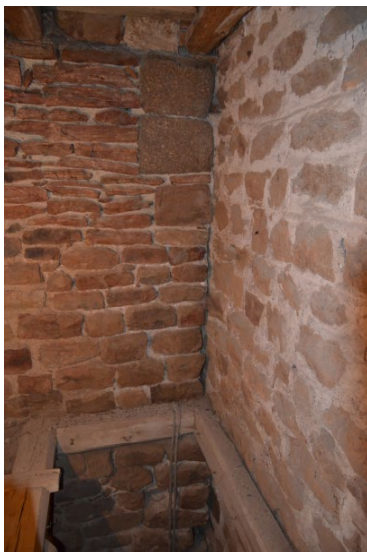
18/ Nárožní armatura a kvádřikové zdivo věže
