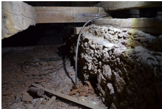
23/ Původní trámy ve starém obvodovém zdivu
