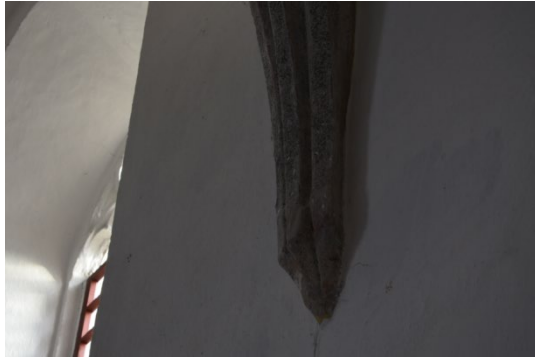
32/ Jehlancová konzola, jižní stěna presbytáře
