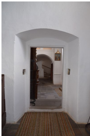
38/ Portál v západní zdi bývalé gotické sakristie do severní kaple lodi
