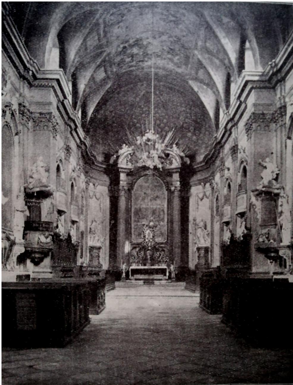
29 Interiér hlavní chrámové lodi v roce 1935.
