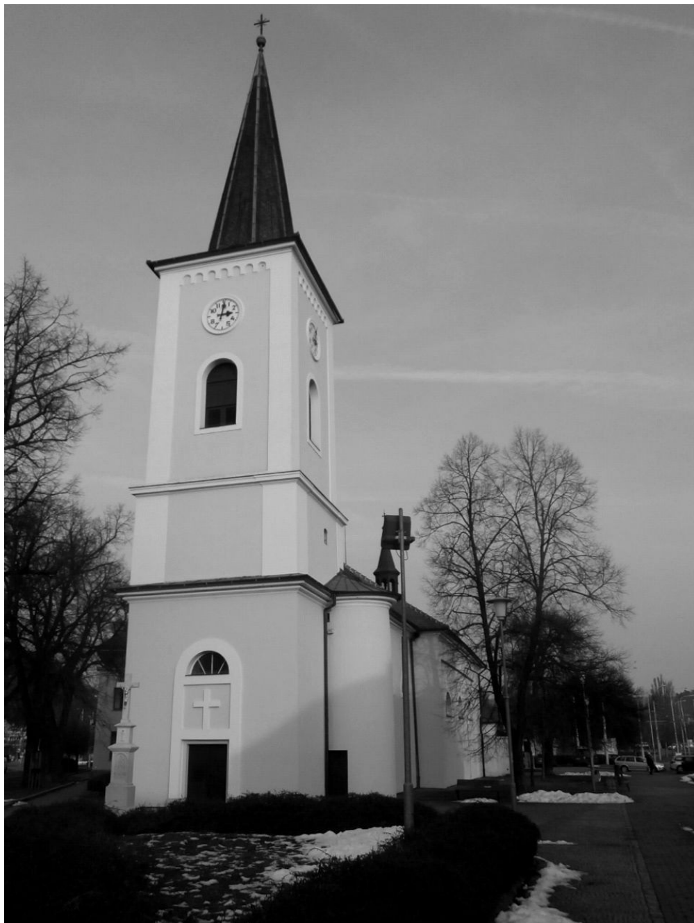
62 Exteriér farního kostela svatých Janů v Brně-Bystřci roku 2018.
