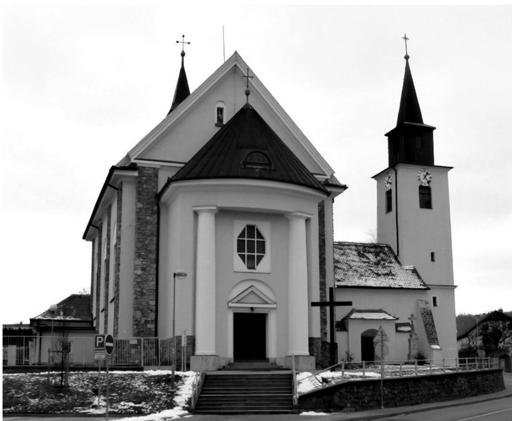
65 Exteriér farního kostela sv. Vavřince v Brně-Žebětíně roku 2018.
