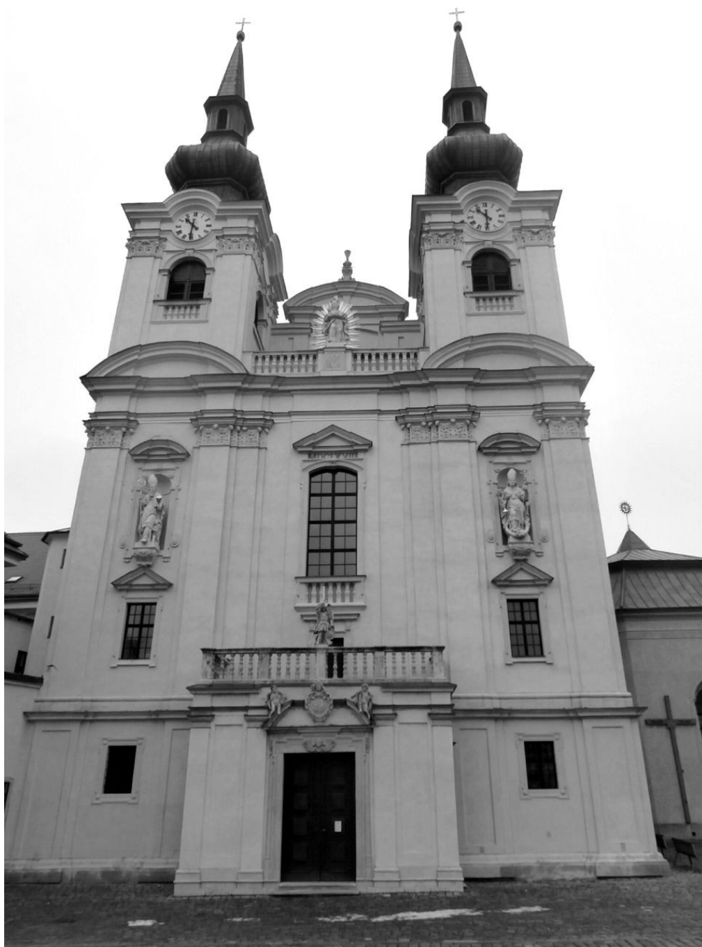
28 Exteriér farního kostela Nanebevzetí Panny Marie v roce 2018.
