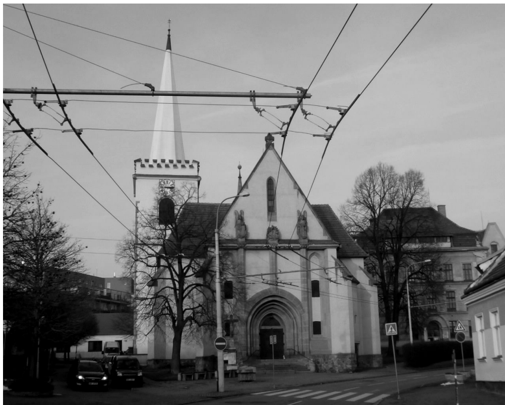
59 Exteriér farního kostela sv. Vavřince v Brně-Komíně roku 2018.
