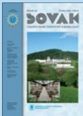
Titulní strana: Úpravná vody Švařec, ve výřezu armaturní prostor filtrů. Provozovatel: Brněnské vodárny a kanalizace, a. s.
