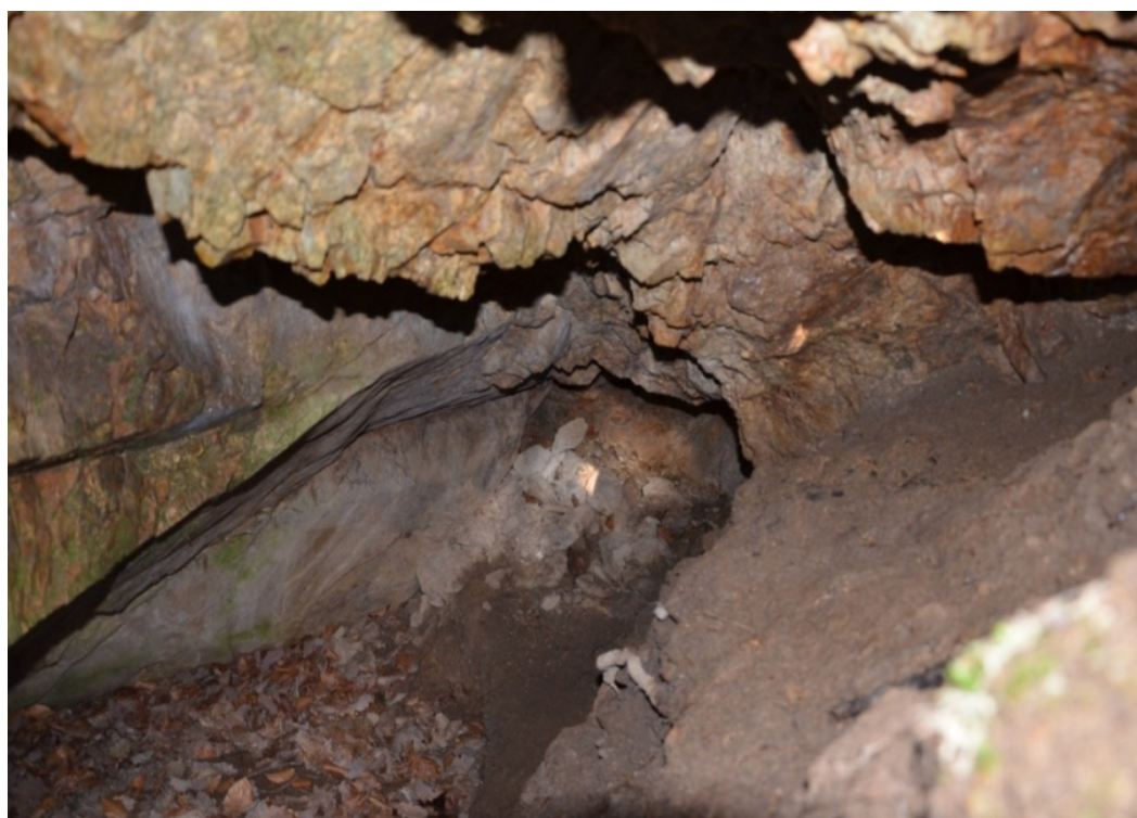
Obr.67.: Fotografie podzemí prostřední linie zlatokopečských stařin. Jedná se propadlý vstup do téměř zasuceného podzemí. Šířka záběru do cca 2 m. Foto: D. Šefčík, 2019.
