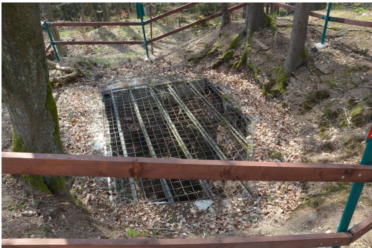
Obr.66.: Vstupy do šachet jsou zabezpečeny proti pádu ocelovou mříží a ohrazeny plotem.
