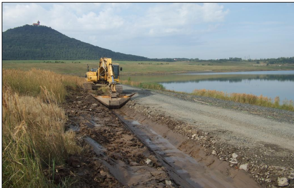
Obr. č. 5 – Budování odvodňovací stružky u jezera Most
