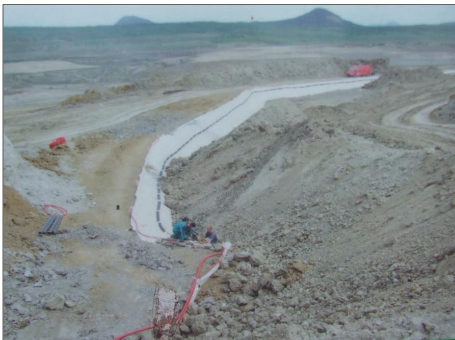
Obr. č. 4 – Rozvod drenáže – Jezero Most
